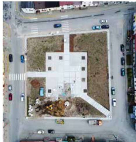
Rynek podczas budowy z lotu ptaka
